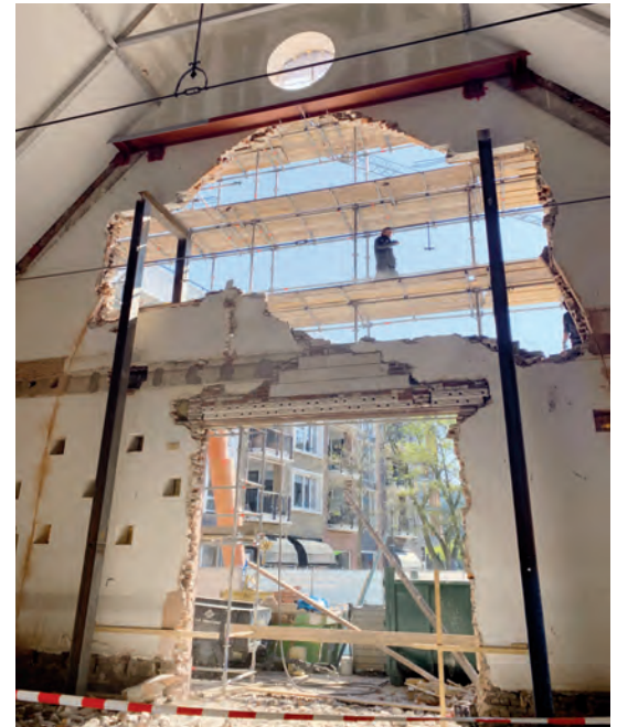
De sparing voor de pui is met een total station afgetekend in de gevel en vervolgens uitgezaagd.
